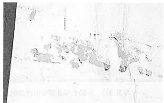
脚中部 主材からの層間剥離
