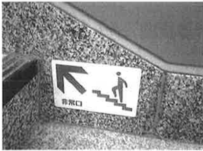
a) 階段壁面下部に設置した樹脂製の明示物
