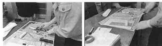
写真-2.4 へら塗り・フィルム貼り付け状況
