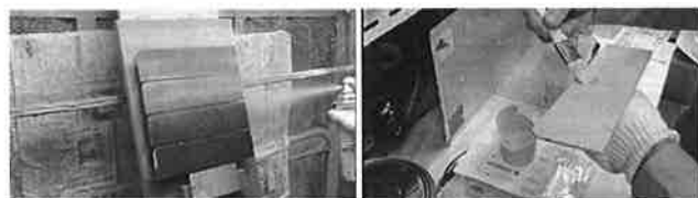
写真-2.2 I7Z-ルイスプレー 塗装状況
